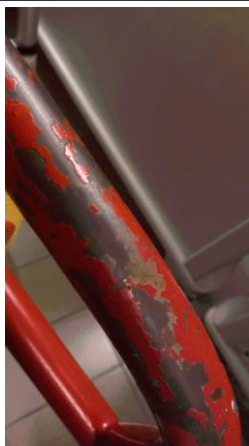
Prélèvement - P025 : BAT 112 - LA BLANCHISSERIE / RDC / DEGAGEMENT 1 1019 - Peinture- (Absence d'amiante)
