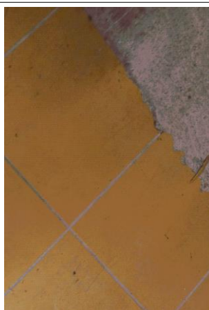
Prélèvement - P052 : BAT 112 - LA BLANCHISSERIE / RDC / LOCAL LESSIVE 1040 - Colle de carrelage- (Absence d'amiante)
