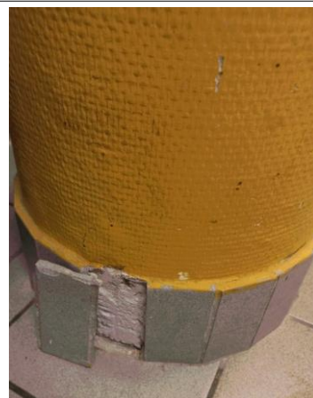
Prélèvement - P030 : BAT 112 - LA BLANCHISSERIE / RDC / DEGAGEMENT 1 1019 - Colle de plinthe- (Absence d'amiante)
