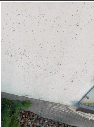
Prélèvement - P081 : BAT 112 - LA BLANCHISSERIE / EXTERIEUR / FACADES - Enduit- (Absence d'amiante)
