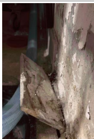
Prélèvement - P054 : BAT 112 - LA BLANCHISSERIE / RDC / LOCAL LESSIVE 1040 - Colle de plinthe- (Absence d'amiante)
