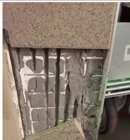
Prélèvement - P044 : BAT 112 - LA BLANCHISSERIE / RDC / LINGE PROPRE 1045 - Colle de faïence- (Absence d'amiante)
