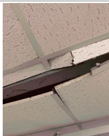
Prélèvement - P046 : BAT 112 - LA BLANCHISSERIE / RDC / LINGE PROPRE 1045 - Faux plafond- (Absence d'amiante)
