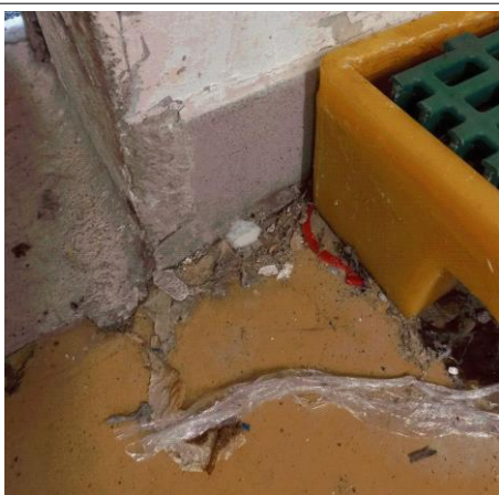
Prélèvement - P053 : BAT 112 - LA BLANCHISSERIE / RDC / LOCAL LESSIVE 1040 - Colle de plinthe- (Absence d'amiante)
