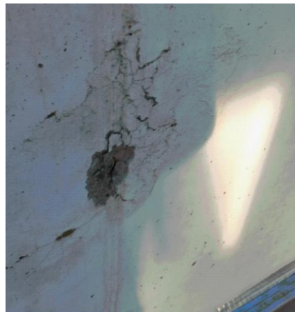
Prélèvement - P080 : BAT 112 - LA BLANCHISSERIE / EXTERIEUR / FACADES - Enduit- (Absence d'amiante)
