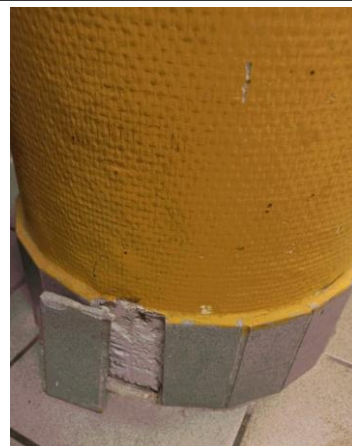
Prélèvement - P032 : BAT 112 - LA BLANCHISSERIE / RDC / DEGAGEMENT 1 1019 - Joint de plinthe- (Absence d'amiante)
