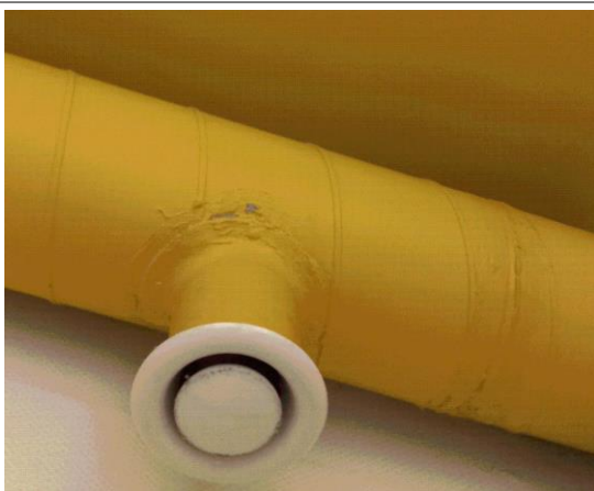
Prélèvement - P017 : BAT 112 - LA BLANCHISSERIE / RDC / VESTIAIRES FEMMES 1003 - Joint- (Présence d'amiante)
