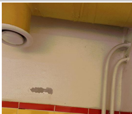
Prélèvement - P010 : BAT 112 - LA BLANCHISSERIE / RDC / VESTIAIRES FEMMES 1003 - Enduit- (Absence d'amiante)
