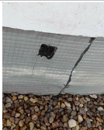
Prélèvement - P086 : BAT 112 - LA BLANCHISSERIE / EXTERIEUR / TOITURE TERRASSE - Relevé d'étanchéité- (Absence d'amiante)
