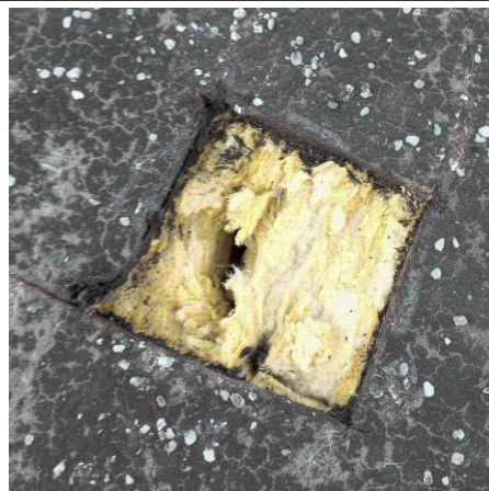
Prélèvement - P092 : BAT 112 - LA BLANCHISSERIE / EXTERIEUR / TOITURE TERRASSE - Complexe d'étanchéité asphalté- (Absence d'amiante)
