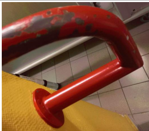
Prélèvement - P026 : BAT 112 - LA BLANCHISSERIE / RDC / DEGAGEMENT 1 1019 - Peinture- (Absence d'amiante)
