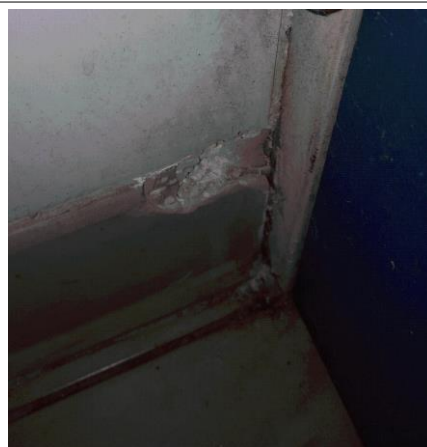
Prélèvement - P018 : BAT 112 - LA BLANCHISSERIE / RDC / LOCAL MENAGE 1017 - Colle de plinthe- (Absence d'amiante)
