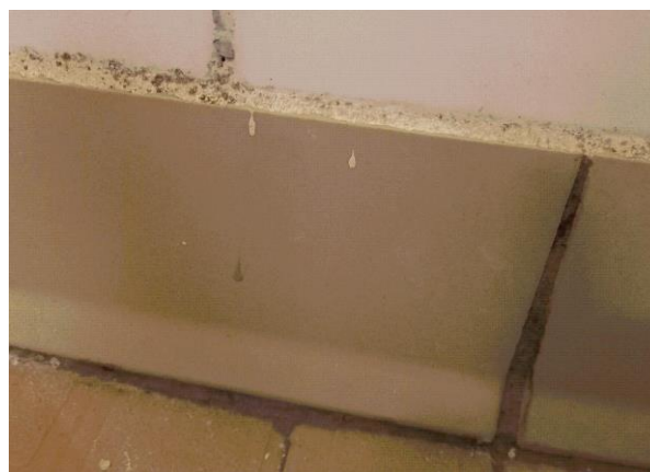
Prélèvement - P012 : BAT 112 - LA BLANCHISSERIE / RDC / VESTIAIRES FEMMES 1003 / DOUCHE 1007 - Colle de plinthe- (Absence d'amiante)
