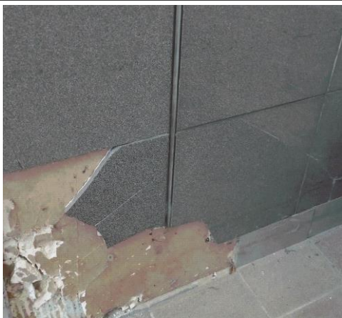
Prélèvement - P037 : BAT 112 - LA BLANCHISSERIE / RDC / HALL DE FINITION 1022 - Colle de faïence- (Absence d'amiante)
