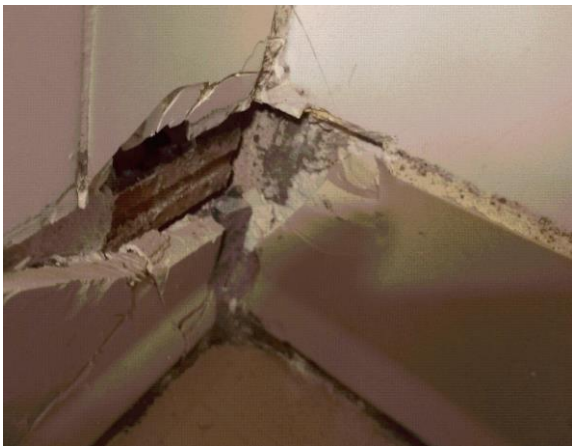
Prélèvement - P013 : BAT 112 - LA BLANCHISSERIE / RDC / VESTIAIRES FEMMES 1003 / DOUCHE 1007 - Joint de plinthe - (Absence d'amiante)
