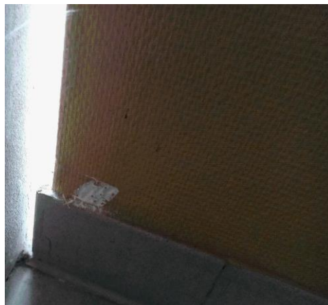
Prélèvement - P002 : BAT 112 - LA BLANCHISSERIE / RDC / DETENTE 1002 - Enduit- (Absence d'amiante)
