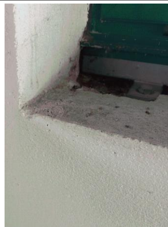
Prélèvement - P068 : BAT 112 - LA BLANCHISSERIE / RDC / STOCKAGE LINGERIE 1039 - Enduit- (Absence d'amiante)
