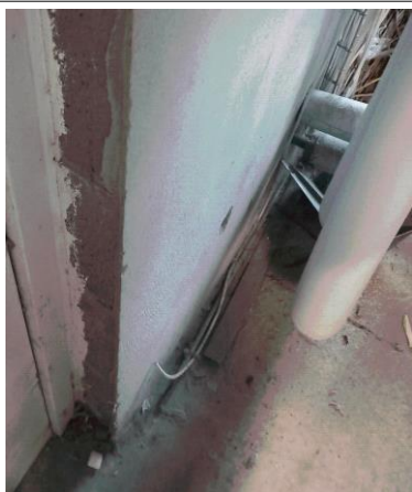
Prélèvement - P047 : BAT 112 - LA BLANCHISSERIE / RDC / CHAUFFERIE 1043 - Enduit- (Absence d'amiante)
