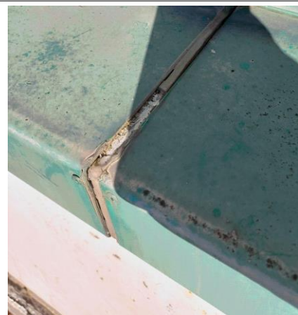
Prélèvement - P082 : BAT 112 - LA BLANCHISSERIE / EXTERIEUR / FACADES - Mastic- (Absence d'amiante)
