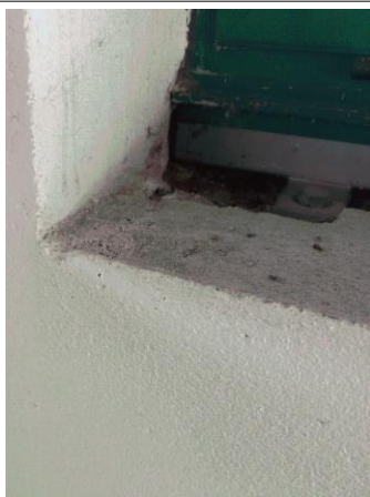
Prélèvement - P069 : BAT 112 - LA BLANCHISSERIE / RDC / STOCKAGE LINGERIE 1039 - Enduit- (Absence d'amiante)
