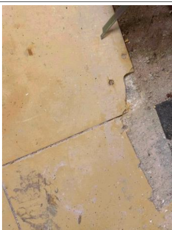
Prélèvement - P051 : BAT 112 - LA BLANCHISSERIE / RDC / LOCAL LESSIVE 1040 - Colle de carrelage- (Absence d'amiante)
