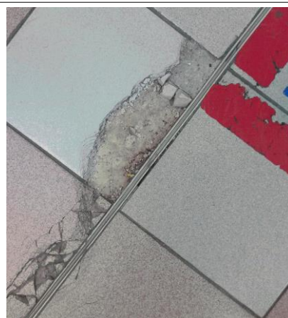
Prélèvement - P036 : BAT 112 - LA BLANCHISSERIE / RDC / HALL DE FINITION 1022 - Colle de carrelage- (Absence d'amiante)
