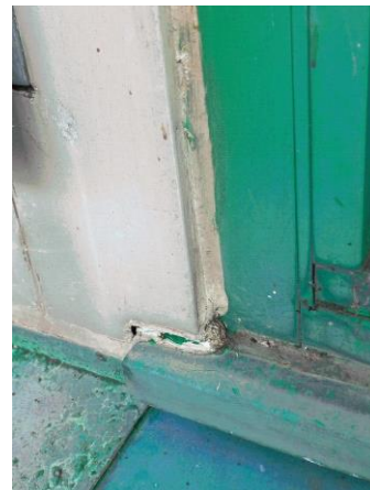
Prélèvement - P084 : BAT 112 - LA BLANCHISSERIE / EXTERIEUR / FACADES - Mastic- (Absence d'amiante)
