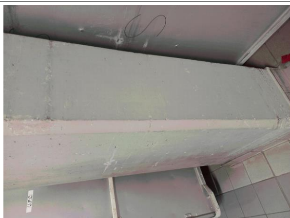
Prélèvement - P035 : BAT 112 - LA BLANCHISSERIE / RDC / HALL DE FINITION 1022 - Enduit- (Absence d'amiante)
