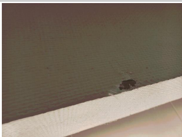
Prélèvement - P021 : BAT 112 - LA BLANCHISSERIE / RDC / DEGAGEMENT 1 1019 - Enduit- (Absence d'amiante)
