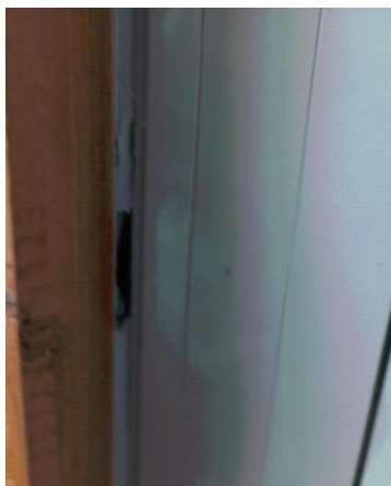
Prélèvement - P003 : BAT 112 - LA BLANCHISSERIE / RDC / DETENTE 1002 - Joint de porte- (Absence d'amiante)
