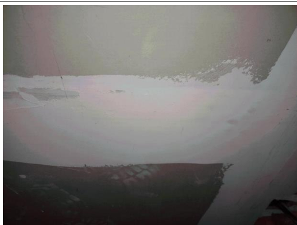
Prélèvement - P045 : BAT 112 - LA BLANCHISSERIE / RDC / LINGE PROPRE 1045 - Bande de plaque de plâtre- (Absence d'amiante)
