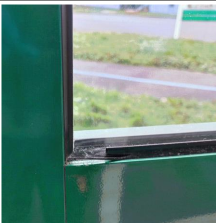
Prélèvement - P005 : BAT 112 - LA BLANCHISSERIE / RDC / DETENTE 1002 - Joint de vitrage- (Absence d'amiante)
