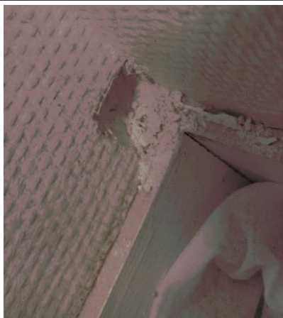
Prélèvement - P073 : BAT 112 - LA BLANCHISSERIE / ETAGE 1 / BUREAU 2008 - Toile de verre- (Absence d'amiante)
