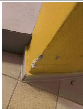
Prélèvement - P024 : BAT 112 - LA BLANCHISSERIE / RDC / DEGAGEMENT 1 1019 - Enduit- (Absence d'amiante)
