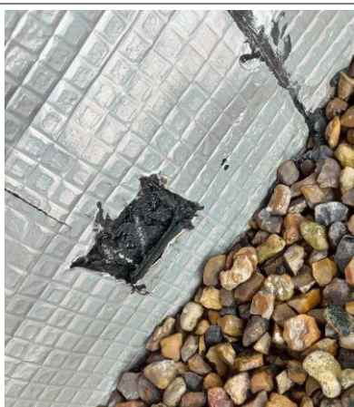
Prélèvement - P089 : BAT 112 - LA BLANCHISSERIE / EXTERIEUR / TOITURE TERRASSE - Relevé d'étanchéité- (Absence d'amiante)
