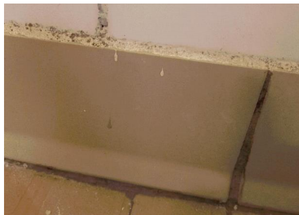
Prélèvement - P014 : BAT 112 - LA BLANCHISSERIE / RDC / VESTIAIRES FEMMES 1003 / DOUCHE 1007 - Joint de plinthe - (Absence d'amiante)
