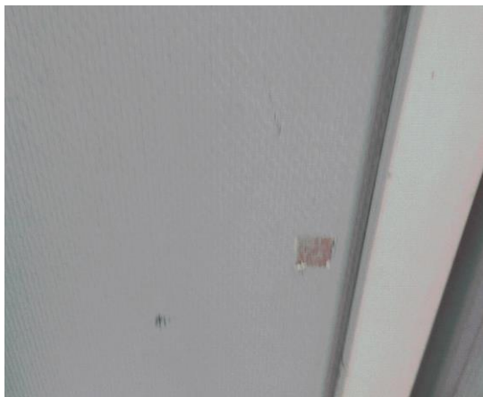
Prélèvement - P001 : BAT 112 - LA BLANCHISSERIE / RDC / DETENTE 1002 - Enduit- (Absence d'amiante)
