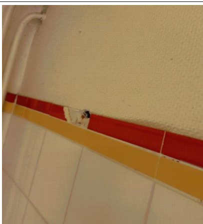
Prélèvement - P009 : BAT 112 - LA BLANCHISSERIE / RDC / VESTIAIRES FEMMES 1003 - Colle de faïence- (Absence d'amiante)
