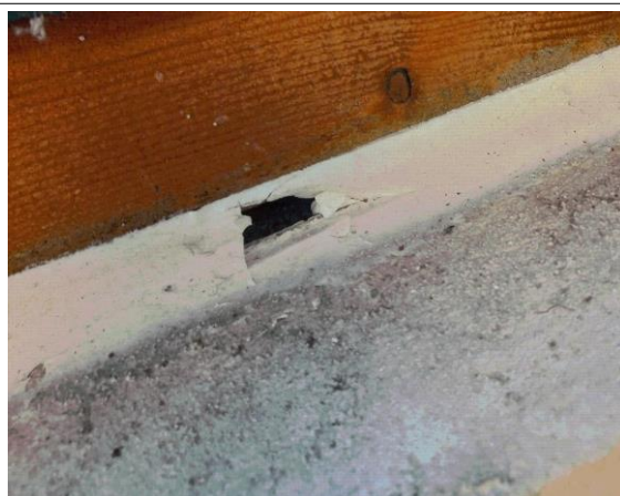
Prélèvement - P064 : BAT 112 - LA BLANCHISSERIE / RDC / BUREAU LINGERIE 1038 - Joint- (Absence d'amiante)
