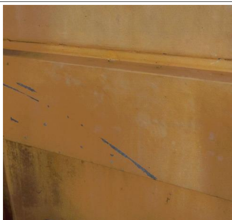
Prélèvement - P058 : BAT 112 - LA BLANCHISSERIE / RDC / LOCAL LESSIVE 1040 - Peinture- (Absence d'amiante)
