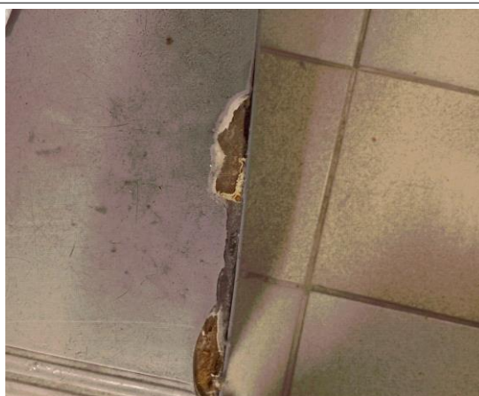
Prélèvement - P028 : BAT 112 - LA BLANCHISSERIE / RDC / DEGAGEMENT 1 1019 - Colle- (Absence d'amiante)
