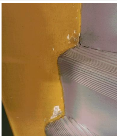
Prélèvement - P023 : BAT 112 - LA BLANCHISSERIE / RDC / DEGAGEMENT 1 1019 - Peinture- (Absence d'amiante)
